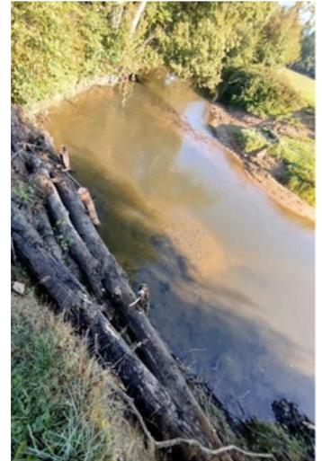
Figure 3 : Mise en place de fascines afin de prévenir l'érosion des berges et maintenir du bois en rivière
